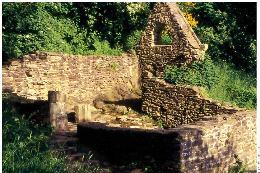
CHAPELLE SAINT-GUÉNOLE SUR LA RIVE GAUCHE DE LA PENFELD À BREST.
